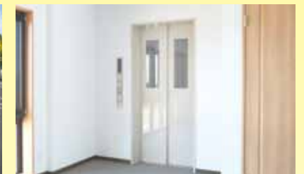
管理棟にはエレベーターも設置。
