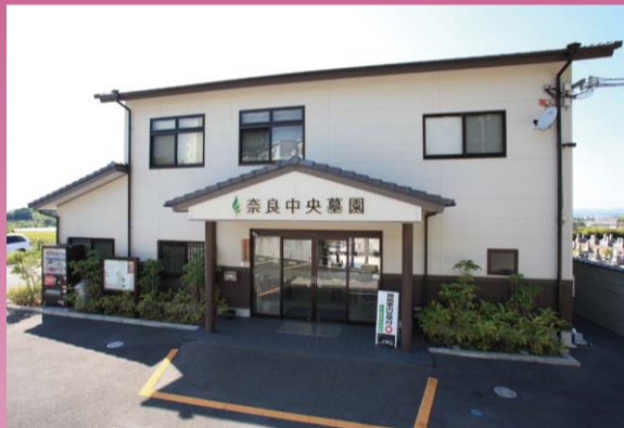
駐車場から段差なしの管理棟。 エレベーターも設置しております。
