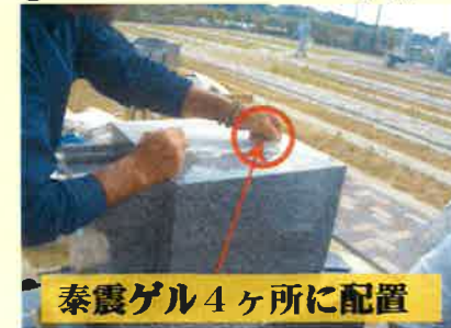
⑪ 上台据付
