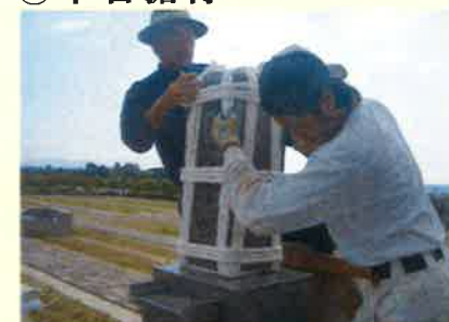
⑮ 竿石据付
