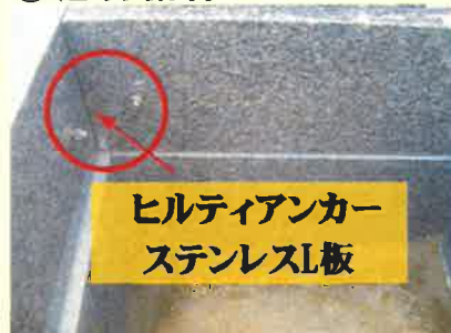
④ 芝台据付
