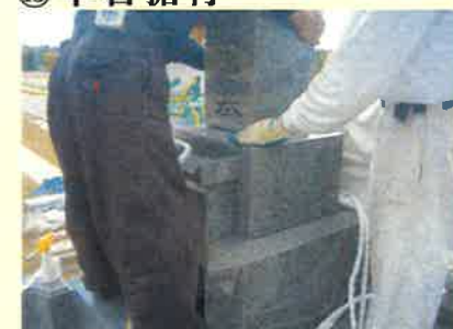
⑯ 竿石据付
