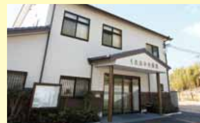
駐車場から段差なしにお参りいただけます。
