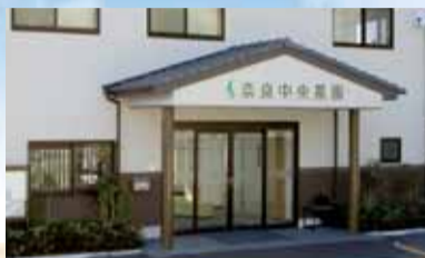
駐車場から段差なしの管理棟。
