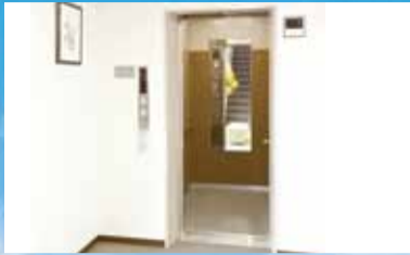
管理棟にはエレベーターも設置。
