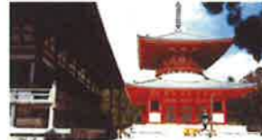
⑤ 根本大塔 / 1937 (昭和12)年に完成した高さ48.5mの朱塗りの大塔。内陣に胎藏界大日如来を本尊として金剛界四仏が安置され、16本の柱と壁に極彩色で描かれた諸尊とともに曼荼羅世界を表しています。
